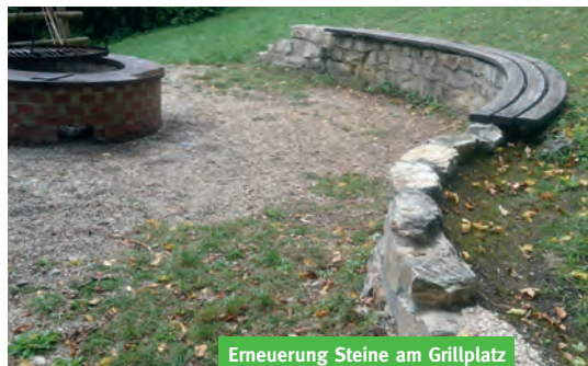
Erneuerung Steine am Grillplatz
